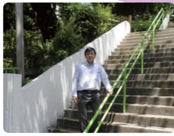
清和公園の階段に滑り止めと手すりを設置
